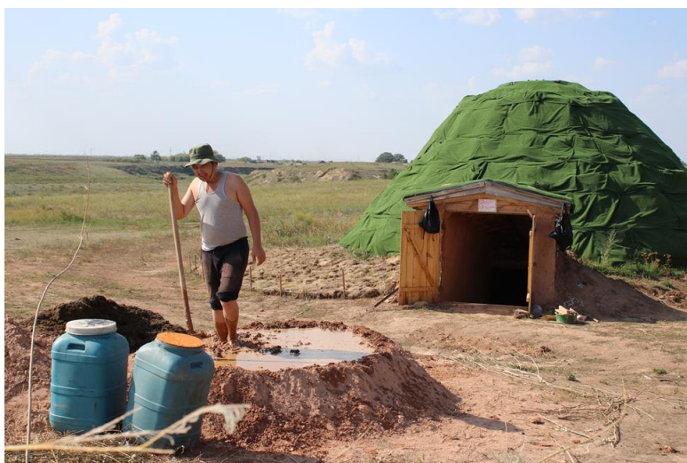
Фотосурет 2 - Ботай ғылыми-эксперименталды тұрғын үйі қызыл саз бен жылқы көңі араласқан батпақ дайындау
