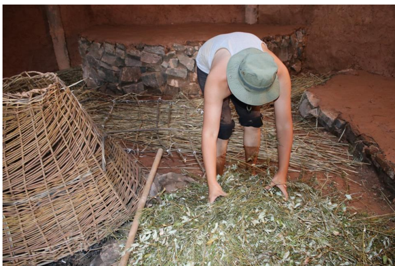
Фотосурет 3 - Ботай ғылыми-эксперминталды тұрғын үйі жылуоқшалау (теплоизоляция) жұмыстары
